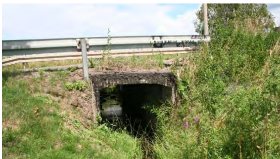
Zdjęcie 10 W Przepust w ciągu drogi nr 1501W
