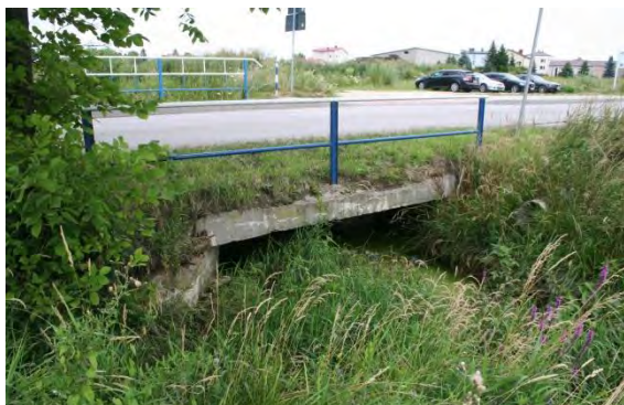
Zdjęcie 9 Przepust w ciągu drogi nr 3122W
