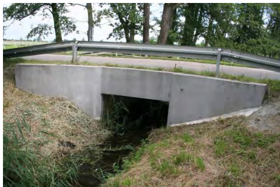
Zdjęcie 11 Przepust w ciągu drogi nr 2842W
