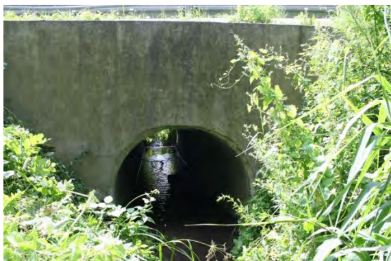
Zdjęcie 12 Przepust w ciągu drogi nr 3102W
